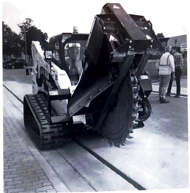
Fräsen? Kein Problem: WirliebenKabel kann bis zu 500 m Kabel am Tag verlegen
