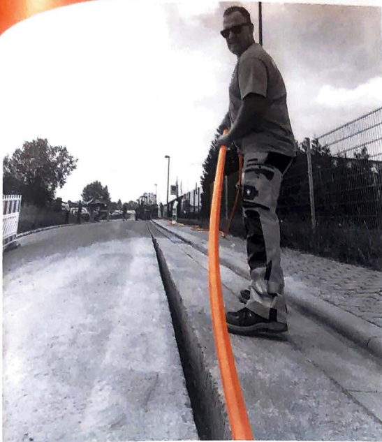
Dank optimaler Planung kann das Verlegen der Kabel teilweise erheblich früher erfolgen, als es bisher möglich war
